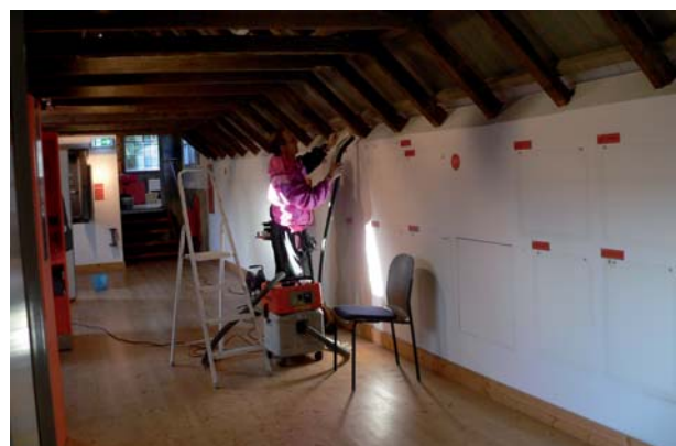
Frank: Speicher Balken, Wände alles wird abgestugt
